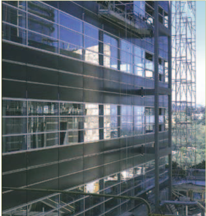
Integratie van bouw, installatie en onderhoud levert goede gebouwen op.
