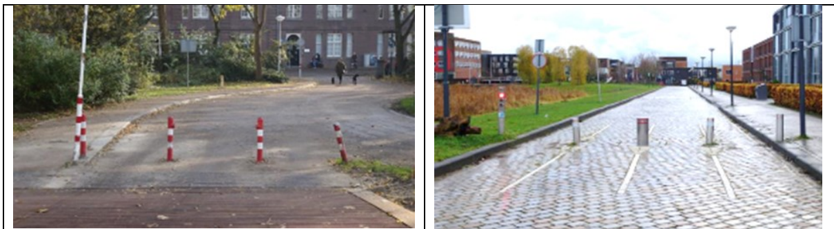
Entrepotdok: paaltjes zonder inleidende markering, vlak na brug
