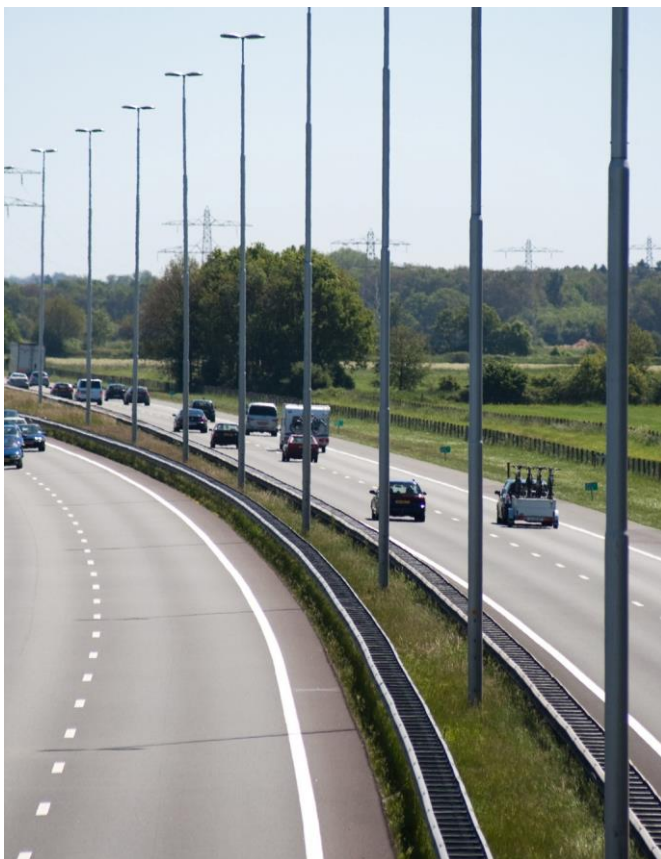
Er bevindt zich gevaar achter de masten, dus is een geleiderail noodzakelijk.
