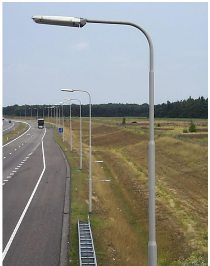
Er bevindt zich minder gevaar achter de mast. Een geleiderail zou niet nodig zijn als de mast botsveilig is.
