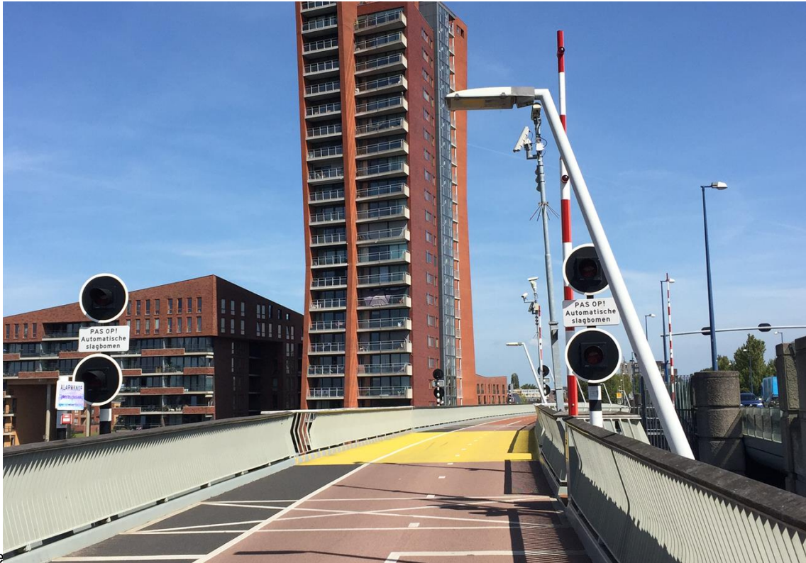
Figuur 1: het oorspronkelijke ontwerp van het gele vlak met geel geschilderd beweegbare deel van de dr. J.M. den Uylbrug.
